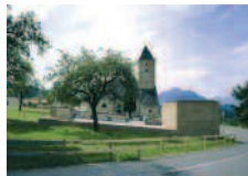
Quelques exemples de réalisations sur la commune de Zwischenwasser
