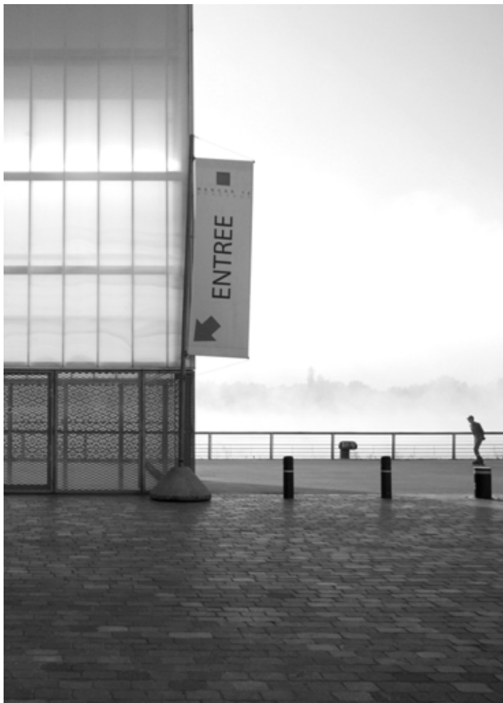
L'entrée fléchée du hangar 14 reconverti en lieu d'expositions et de manifestations sur le quai des Chartrons par un dimanche matin brumeux d'octobre (Flint + Lanoire & Courrian, arch.).
