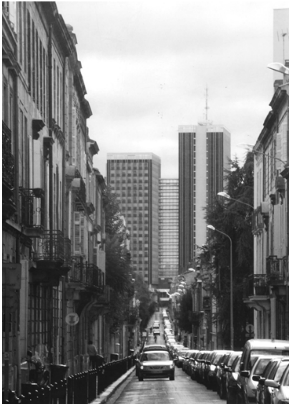
La cité administrative et ses tours reliées, irruption de la modernité de l'ère Chaban-Delmas saisie dans l'axe d'une rue du Bordeaux historique (Pierre Mathieu, arch., 1948-1974).
