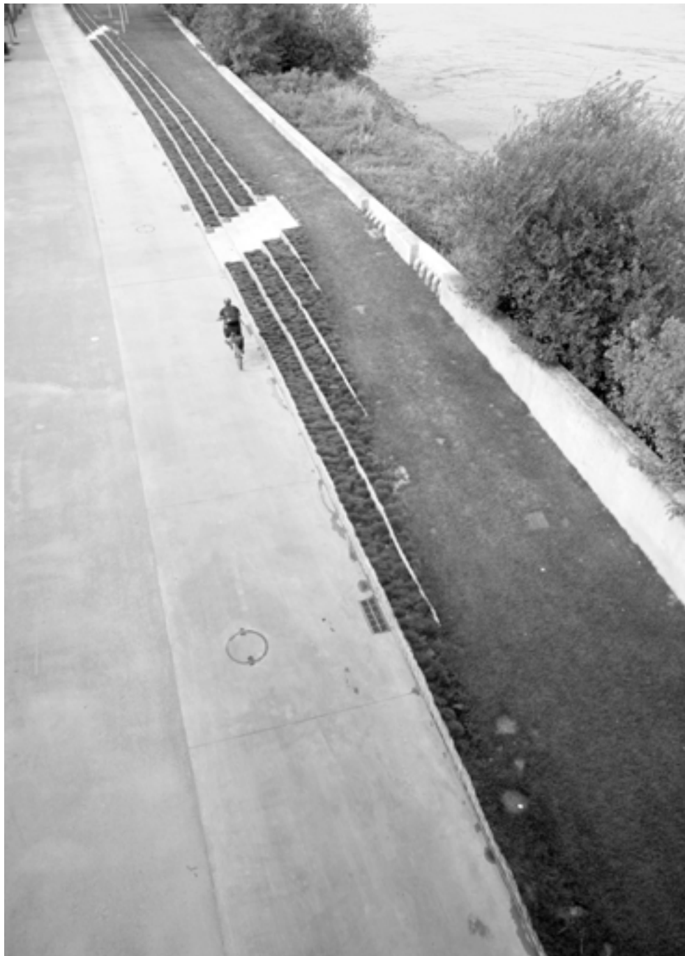
Le niveau bas de la berge de la rive gauche reconquise pour la promenade, à l'aplomb du pont de Pierre (Michel Corajoud, paysagiste, mandataire de l'équipe de maîtrise d'œuvre urbaine).
