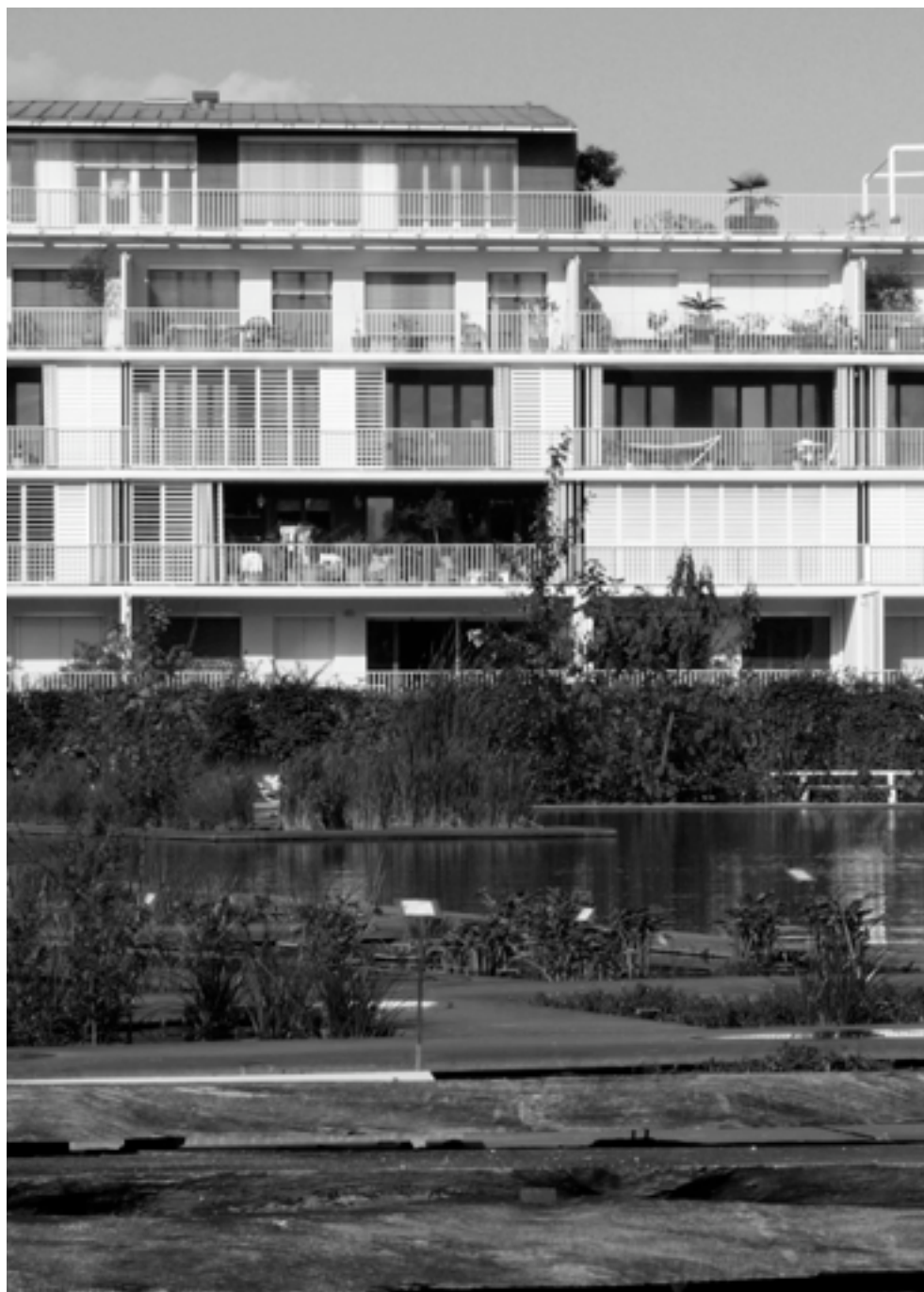
Résidence "Cœur de Garonne" (Brochet-Lajus-Pueyo, arch., 2001) donnant sur le jardin botanique (Catherine Mosbach, paysagiste, 2001-2004), au centre de la ZAC Cœur de Bastide.
