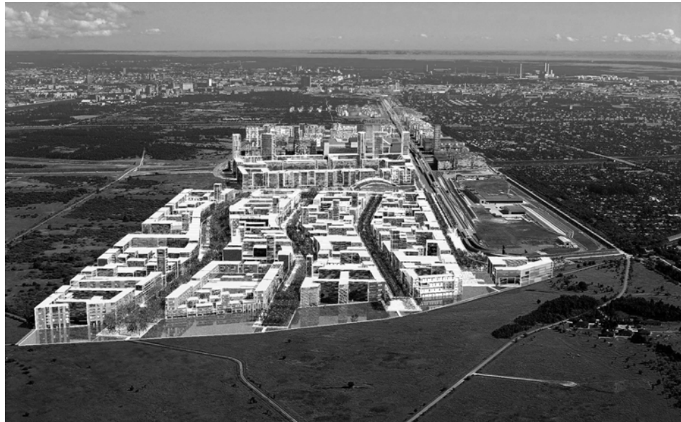
L'extrémité sud d'Ørestad au contact des zones naturelles protégées, non loin de l'aéroport de Copenhague-Kastrup (perspective du projet GHB + Bystrup à l'horizon 2020).
