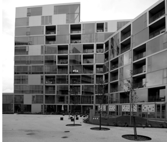
Immeuble M de l'opération VM (PLOT arch. : Bjarke Ingels + Julien De Smedt).
