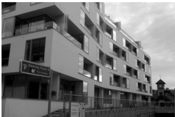
Immeuble d'habitation sur Amerika Plads (C. F. Møller, arch., 2006)
