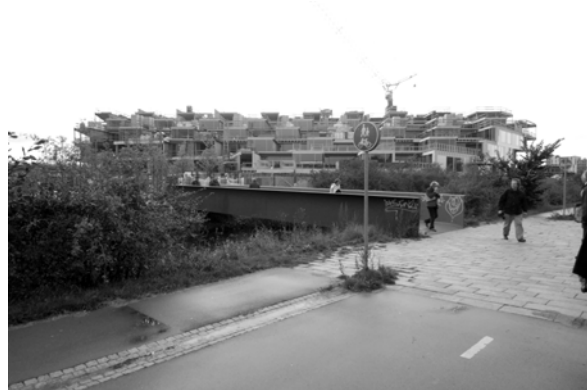
Immeuble MTN en cours de construction (BIG, arch.).
