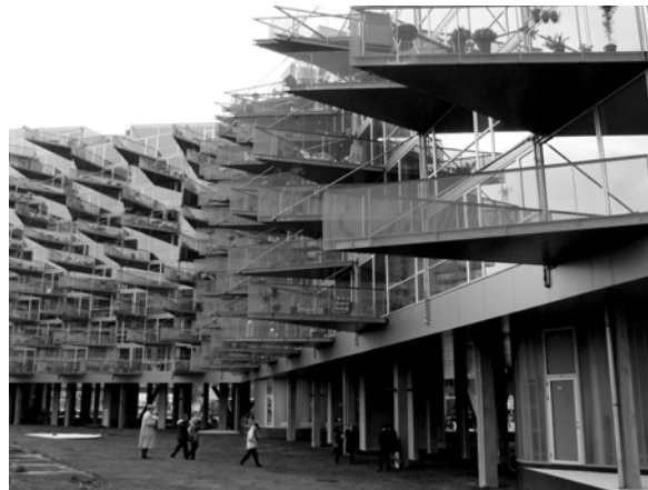
Immeuble V de l'opération VM (PLOT, arch. : Bjarke Ingels + Julien De Smedt).
