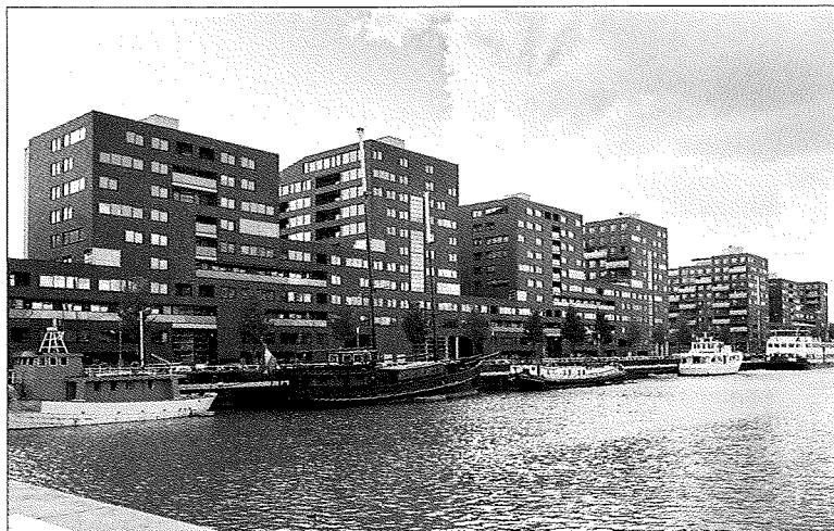
Rotterdam, Kop Van Zuid, 625 logements, Architekten Cie
