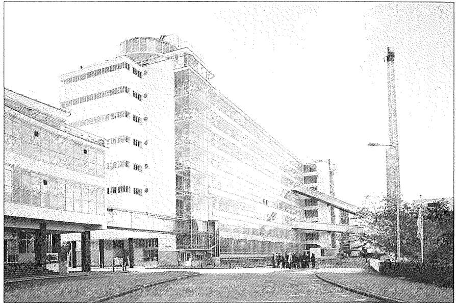
Rotterdam, usine Van Nelle 1925-1931, architectes J.A. Brinkman et L.C. Van der Vlugt
