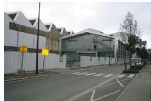
Hangar rénové, architecte Lipsky-Rollet.
