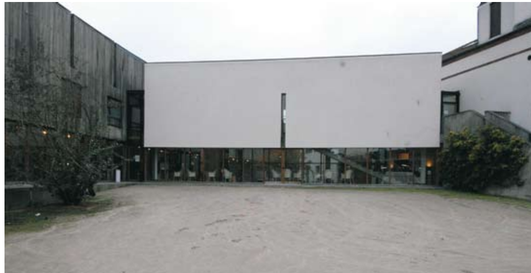
École nationale supérieure d'architecture de Bretagne, architecte Patrick Berger.
