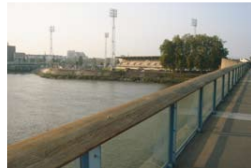
Passerelle sur la Loire, architectes Barto+Barto.
