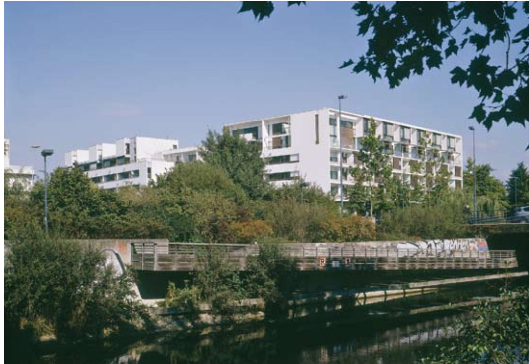
Port-Saint-Martin, architecte Michel Kagan.
