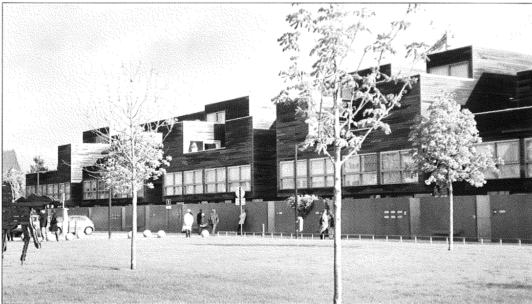
Façades en bois et béton lazuré sur l'espace intérieur
