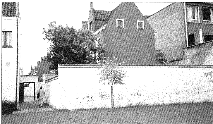
De l'arrière du béguinage vers une ruelle de desserte des maisons
