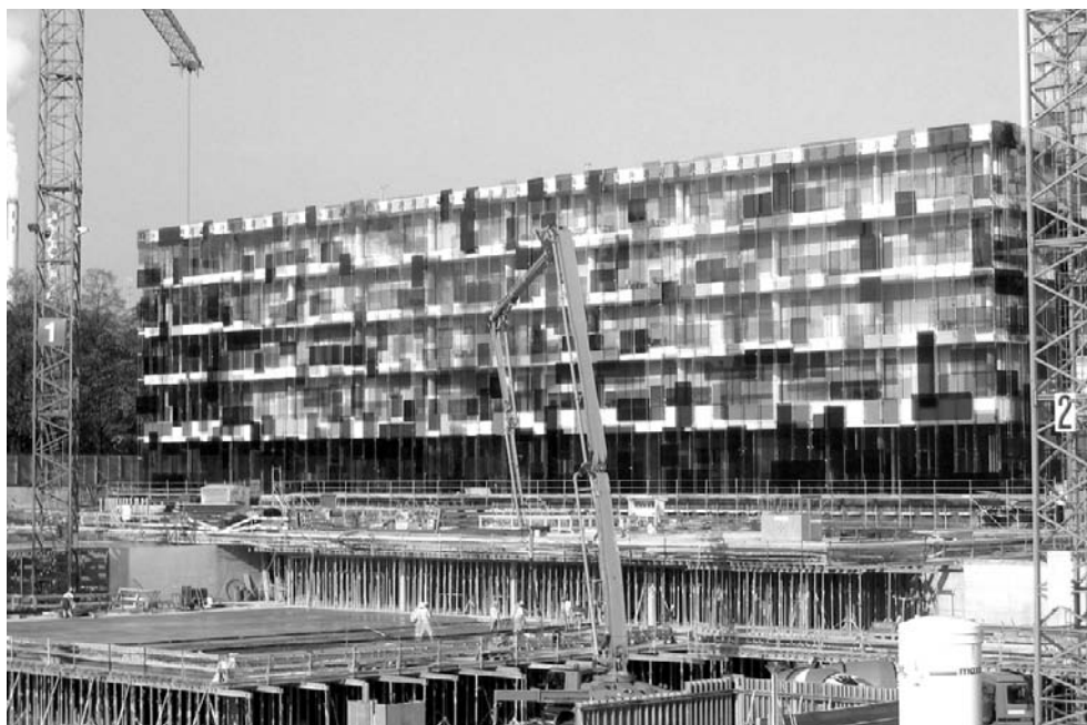
Immeuble Forum 3, Campus Novartis. Diener & Diener, Wiederin et Federle, architectes, plasticien.
