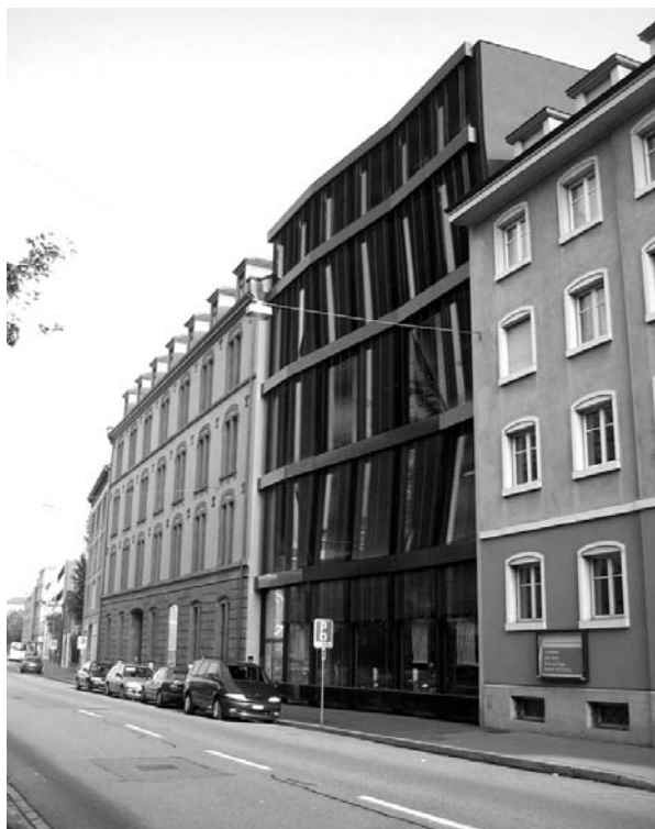
Projet bâlois non identifié à proximité de l'hôpital.
