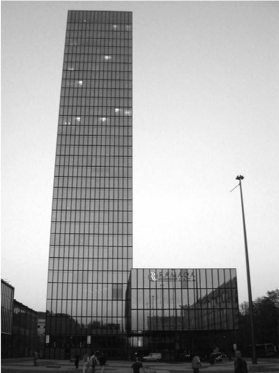
La tour de la Foire de Bâle - notre hôtel - nouvelle et unique émergence de la ville sur la rive orientale. Morger & Degelo, avec Daniel Marquez, architectes. 2000-2003.
