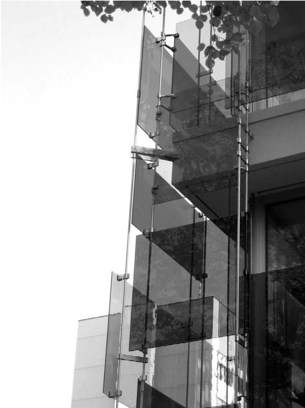
Les vitrages colorés superposés de l'immeuble d'activités Forum 3 du Campus Novartis. Diener & Diener, Wiederin et Federle, architectes et plasticien.
