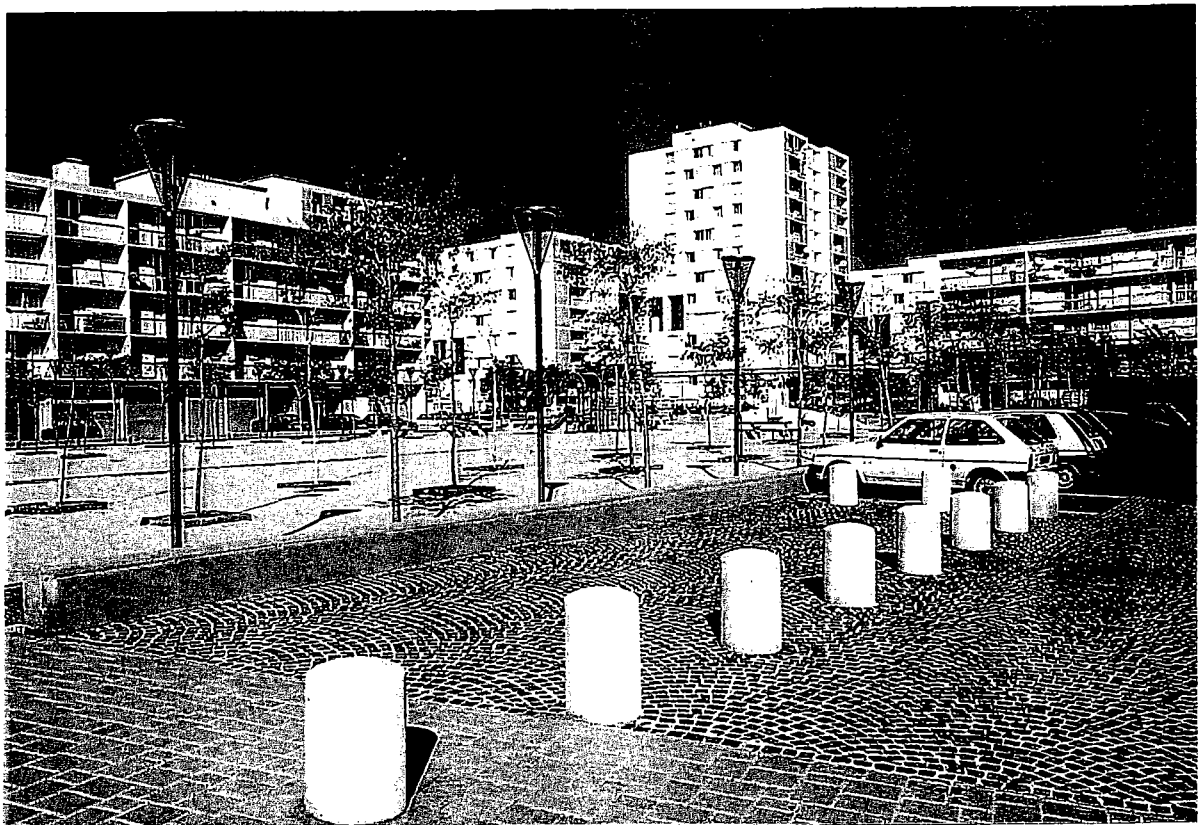
Opération visitée : Les Aigues-Douces à Port de Bouc Réhabilitation du grand ensemble par Massimiliano Fuksas et Alain Amedeo pour l'OPAC Sud, 1997.
